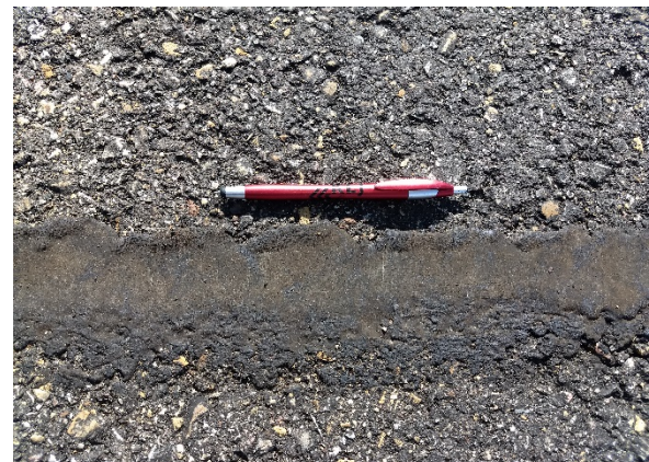
T-6, Sealed Crack
